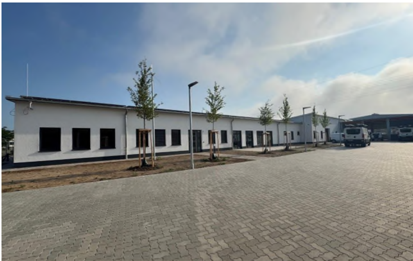
Büro, Werkstatt und Fahrzeughalle in einem: Das Netzteam Vorderpfalz hat die neue Dienststelle in den Seewiesen in Edenkoben bezogen.
