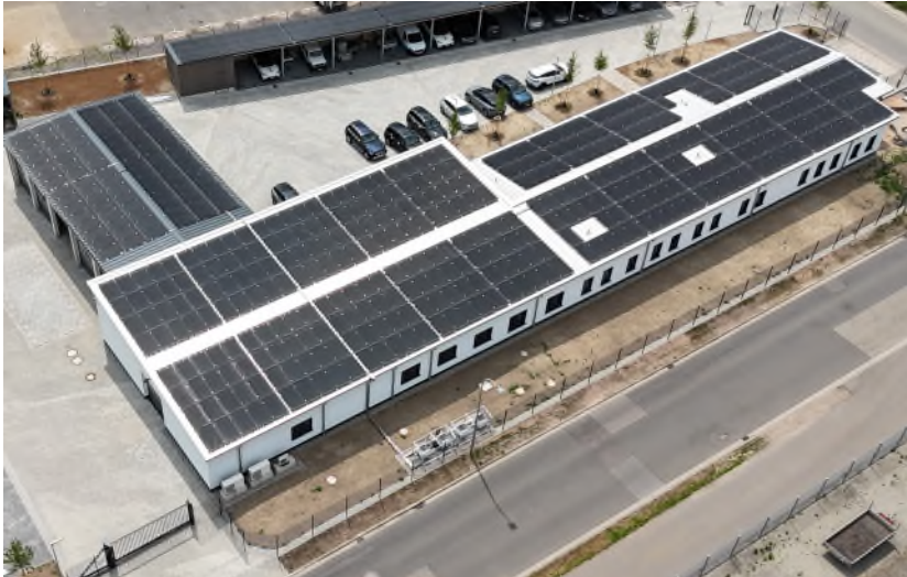
Die Drohne offenbart die große PV-Anlage, die die neue Dienststelle der Pfalzwerke Netz AG in Edenkoben mit Strom versorgt.
